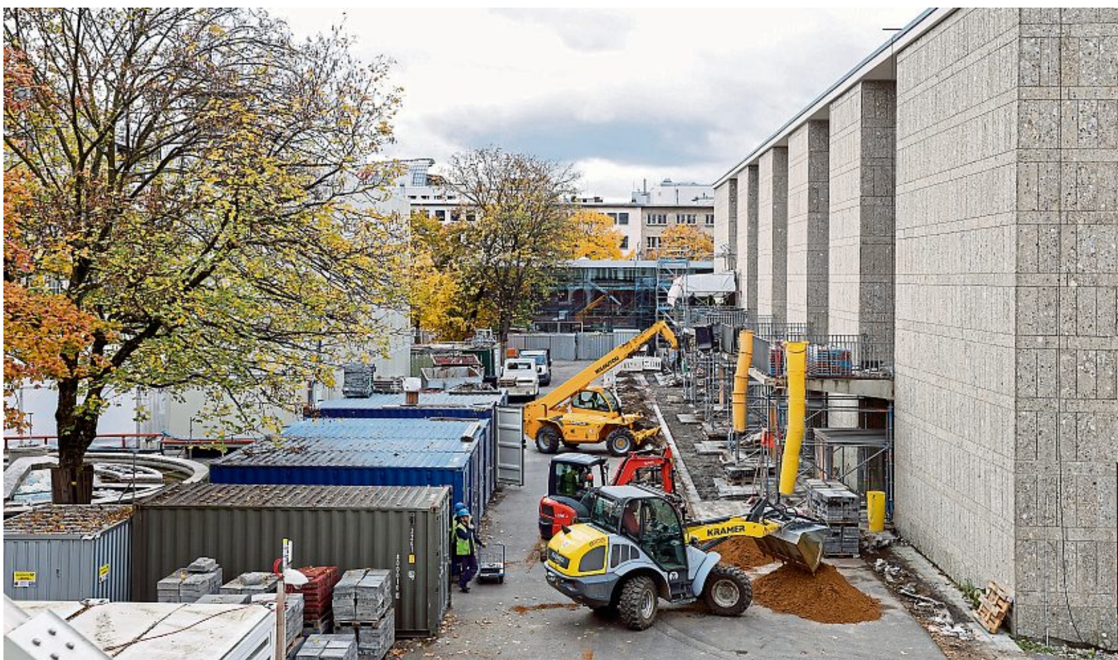
Seit 2012 dauern die Sanierungsarbeiten an Kölner Oper und Schauspielhaus an. Das Foto zeigt die Baustelle in November 2023.
